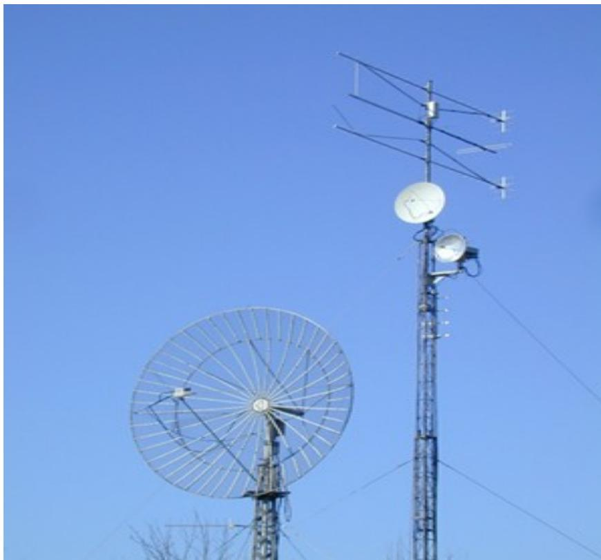
Zum obigen Bild schreibt DB6NT: „Aufnahme um 2005: Nach einem Sturmschaden wurde die 70cm Antenne verkleinert. Die Antennen für 5,7GHz und höher wurden auf dem 10m Mast angebracht. Der Grund für diese Maßnahme war das „Hochwachsen“ der Bäume im angrenzenden Gelände.“
