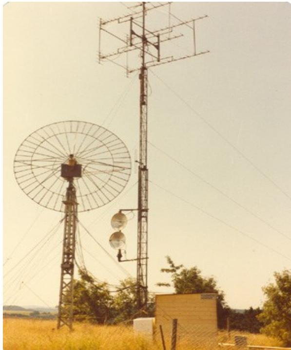
Hier ist bereits die Holzhütte gut zu erkennen, lange Zeit die Unterkunft der Operateure und auch kleiner Nagetiere! Strom wurde mit einem Dieselgenerator erzeugt. Weiter merkt Michael an: Jetzt mit Konni- Antennen und 4m Spiegel. Im Holzkasten befanden sich die Endstufen mit 2C39 bestückt, welche auf 23cm und 13cm ihren Dienst versahen.
