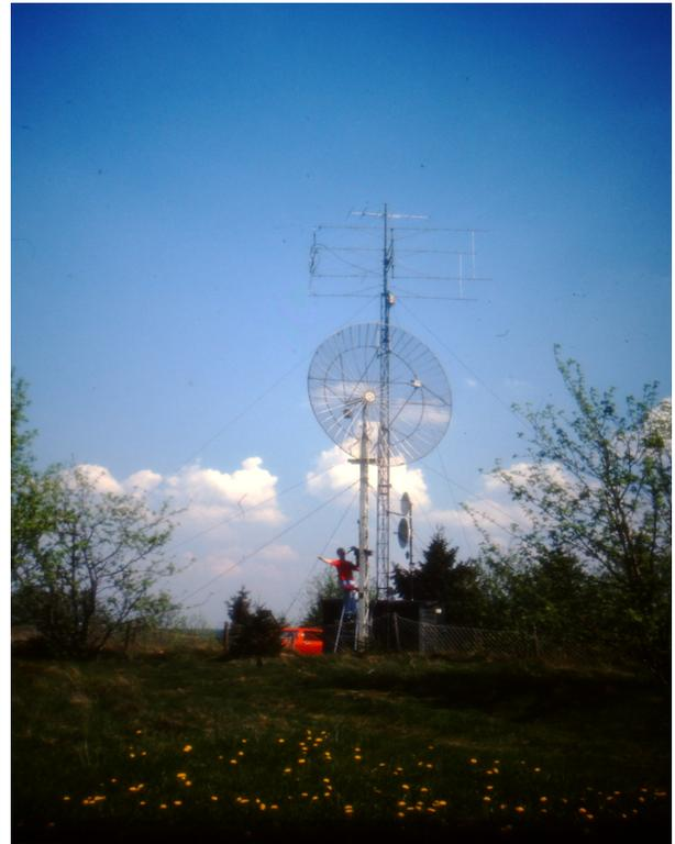
So sieht es nun 2016 bei DK0NA aus: Die Station ist in einem 2001 aufgestellten Alucontainer untergebracht, welcher klimatisiert werden kann. Ein neuer, leistungsfähiger Generator stellt die Energieversorgung sicher. Für 144MHz gibt es eine 2x9 Elementantenne, auf 432MHz sind 4x 25 Elemente im Einsatz, 5,7 bis 47GHz werden durch Verwendung von 1,2m Spiegeln abgedeckt. Ebenfalls am Mast befindet sich die Anlage für 76GHz sowie für Laserversuche.
